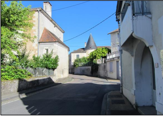
Centre-bourg de Agonac Source : Artifex 2020
