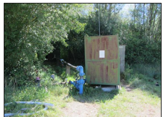
Forage pour l'irrigation au Sud du site d'étude Source : Artifex 2020
