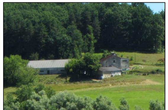
Habitation la plus proche à « Borie des Cailloux » Source : Artifex 2020
