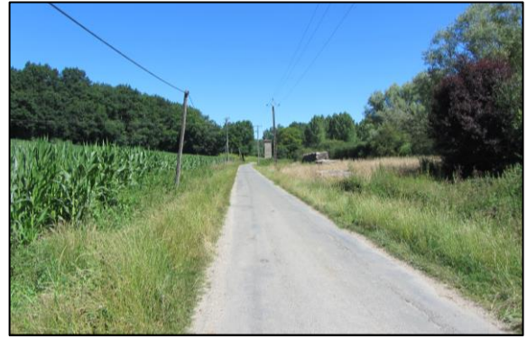
Voie communale n°203 au niveau du site d'étude Source : Artifex 2020
