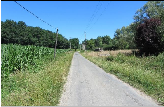
Voie communale n°203 au niveau du site du projet
